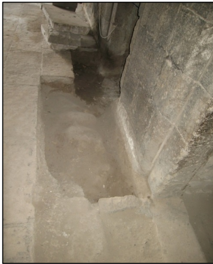
Foto. 62: Eşiklerin önünde yapılan sondaj çalışması
