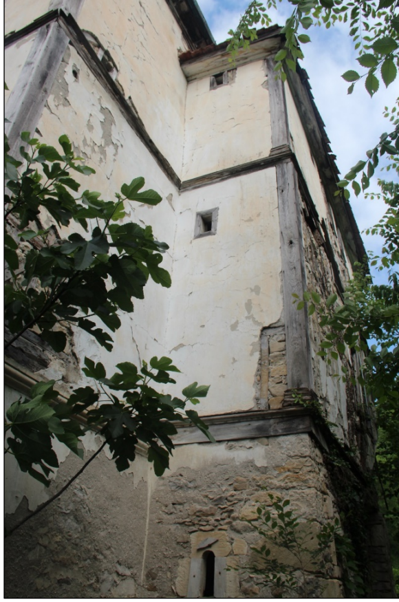
Foto. 6: Konağın Güney Cephesi
