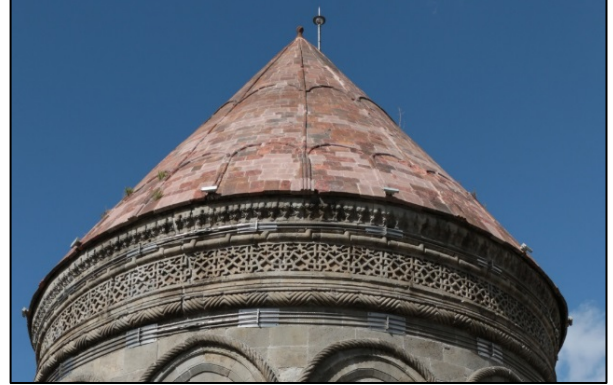
Foto. 21: Trbenin klah altı kuřađı (onarım sonrası)
