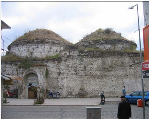
Foto. 15: Batı Cephe (Onarım Öncesi)
