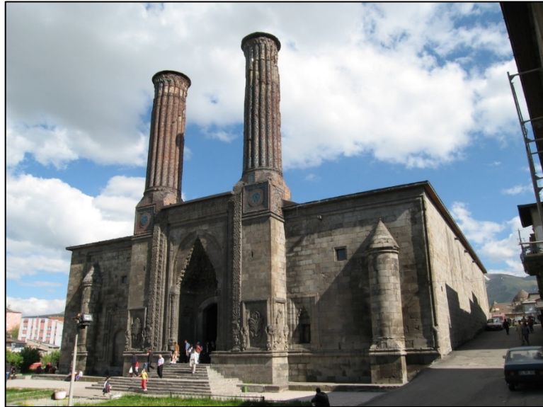
Foto. 1: Çifte Minareli Medrese'nin onarım öncesi genel görünümü
