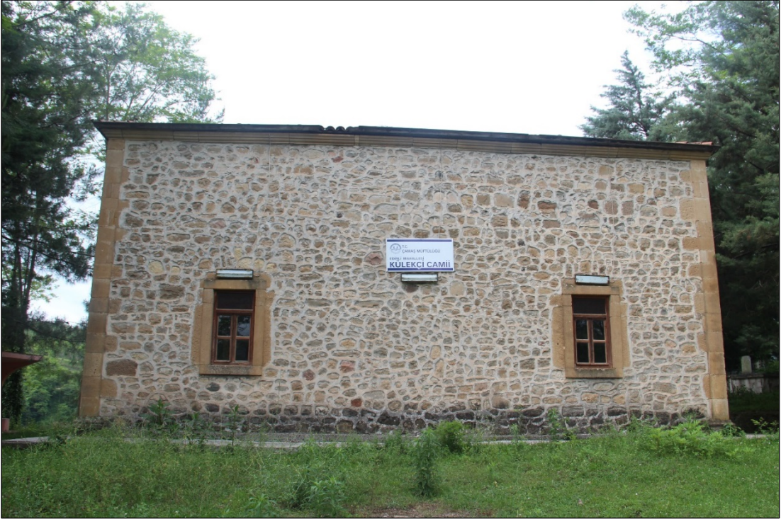
Foto. 18: Caminin Güney Cephesi
