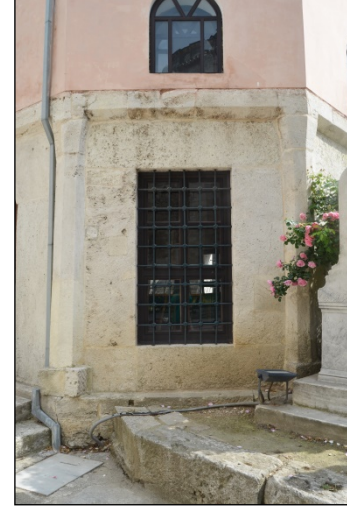
Foto. 12: İstanbul, Hatice Sultan Türbesi, Taş Panel Duvarlar
