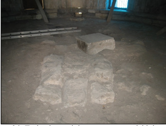
Foto. 24: Türbenin zeminin onarım sırasındaki durumu
