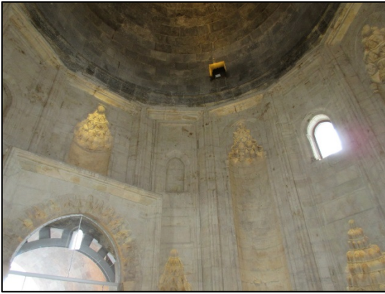
Foto. 22: Trbe iinde temizlenen yzeyler ve kubbe
