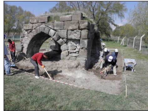
Foto. 3: Dört Kemerli Yapı Çevresindeki Çalışmalar
