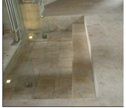
Foto. 25: Türbe zeminini ve kapı eşiğinin onarım sonrası durumu
