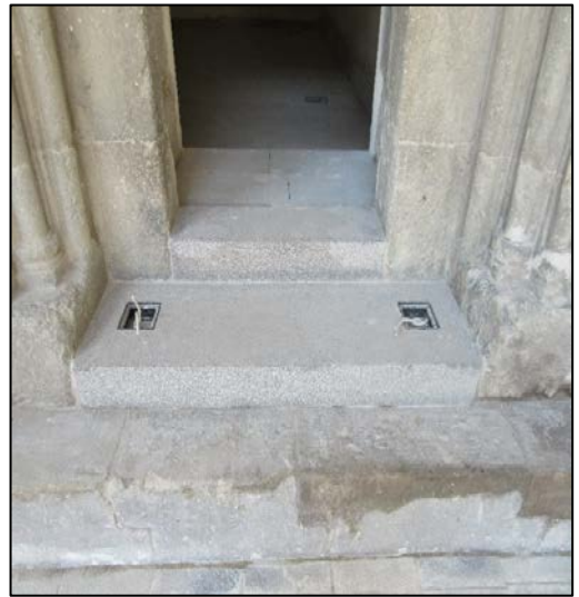
Foto. 63: Eşiklerin restorasyon sonrası durumu ve led aydınlatmalar
