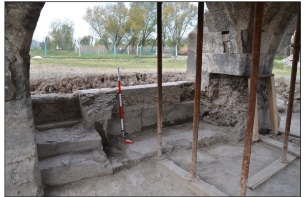
Foto. 16: Dört Kemerli Yapı, İç Kısımdaki Merdiven
