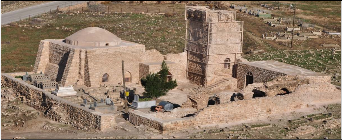
Foto. 15: İmam Abdullah Zaviyesi (Külliyesi), restorasyon sonrası görünüşü.
