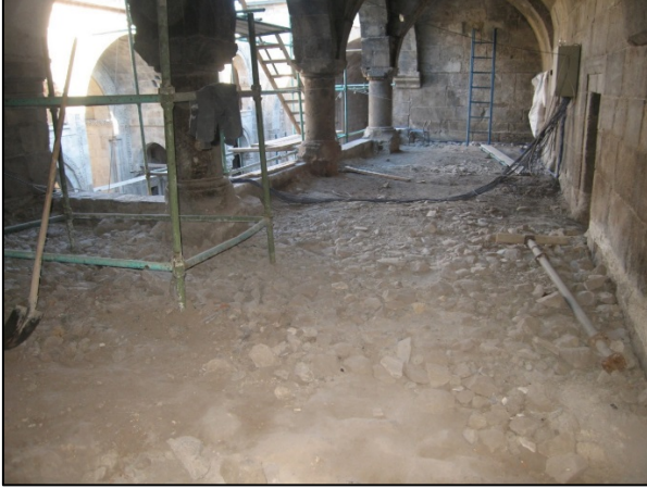
Foto. 64: Kuzeybatı üst kat revakın restorasyon öncesi durumu
