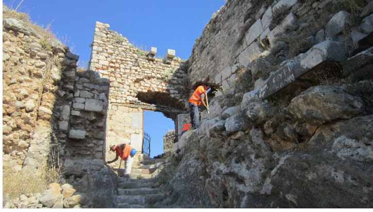
Foto. 1: Temizlik Çalışmaları (İç Kale Merdivenleri)
