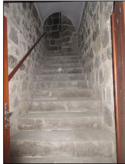
Foto. 58: Batı üst kata çıkan merdiven (restorasyon öncesi)
