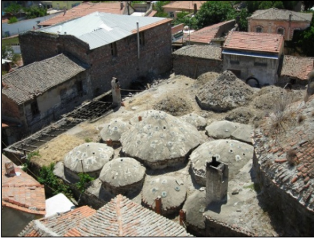
Foto. 19: Örtü sistemi (onarım öncesi)
