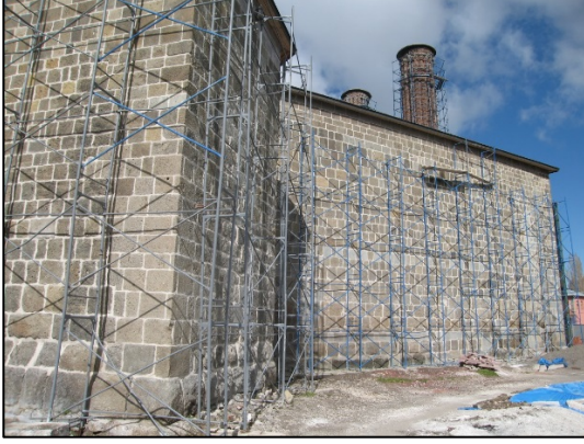
Foto. 42: Doğu cephenin restorasyon sırasındaki durumu
