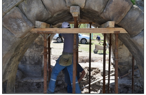
Foto. 12: Dört Kemerli Yapıda Askıya Alma İşlemi
