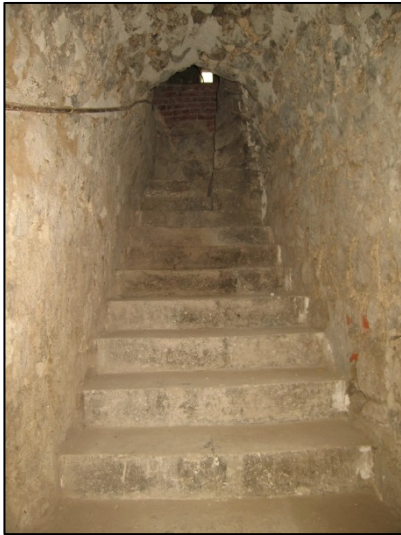
Foto. 57: Batı üst kata çıkan merdiven (restorasyon öncesi)
