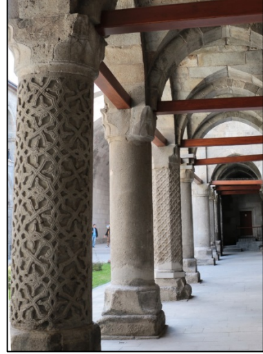
Foto. 65: Revak sütunlarında uygulanan onarımlar
