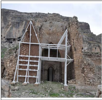
Foto. 18: Koç Camii giriş eyvanı ve koruma amaçlı destekleme sistemi.
