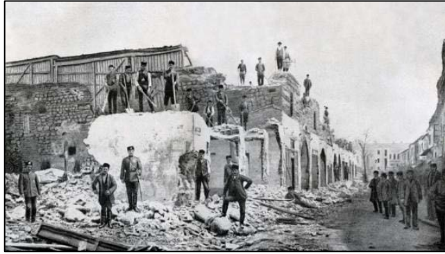
Foto. 39: Yıkım çalışmalarını gösteren eski bir resim
