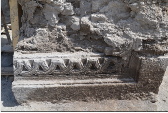
Foto. 13: Dört Kemerli Yapı, Güneybatı Ayak
