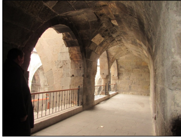
Foto. 66: Restorasyon sonrası balkon ve korkuluk düzenlemesi
