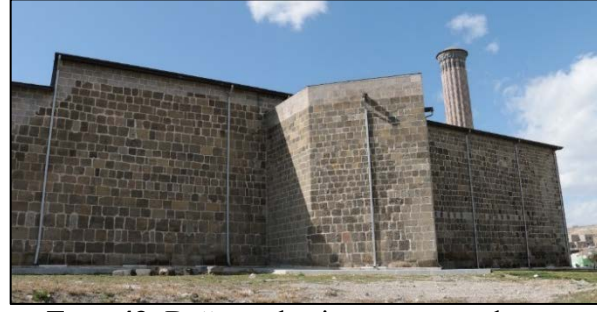
Foto. 43: Doğu cephenin restorasyondan sonraki durumu
