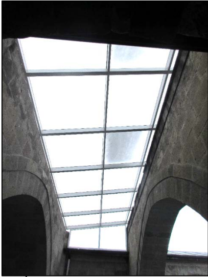
Foto. 52: İki kemer arasında yerleştirilen cam örtü
