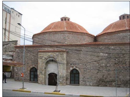
Foto. 16: Batı Cephe (Onarım Sonrası)
