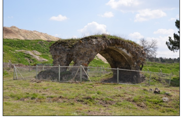
Foto. 18: Tonozlu Yapı Sondaj Öncesi
