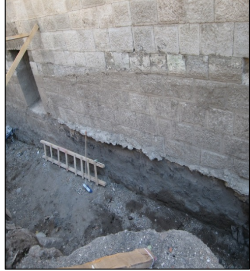
Foto. 37: Restorasyon öncesi batı cephede kot indirme çalışmaları
