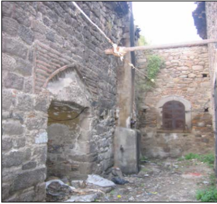
Foto. 7: Kuzey Cephede Kapatılan Pencere
