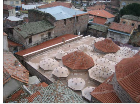
Foto. 20: Örtü sistemi (onarım sonrası)
