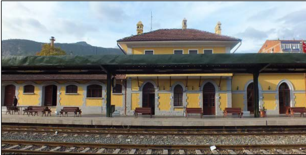
Foto. 6: Güneyden görünüm (ambar, idari bina, bekleme salonu)
