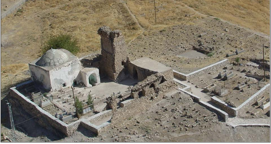
Foto. 14: İmam Abdullah Zaviyesi (Külliyesi), restorasyon öncesi görünüşü.
