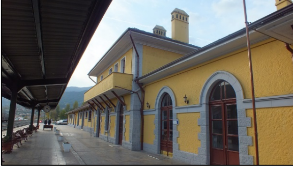
Foto. 7: İdari bina ve sonradan eklenen balkon
