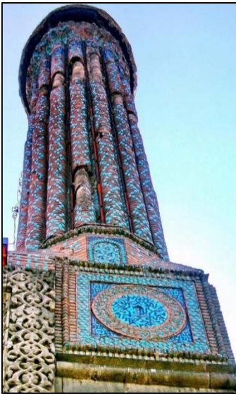
Foto.28: Onarım öncesi sağ minare
