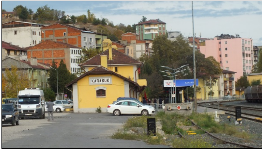
Foto. 19: İstasyon Binası çevresindeki kentsel doku
