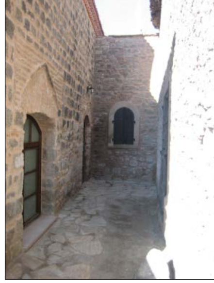
Foto. 18: Kuzey Cephe (Onarım Sonrası)
