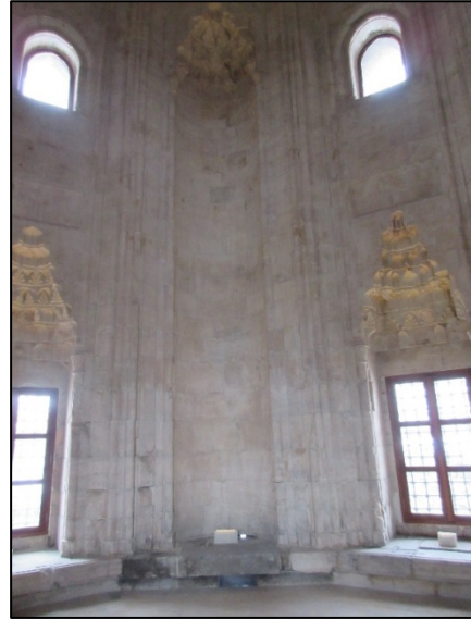
Foto. 23: Trbe iinde temizlenen niř, aıklıklar ve led aydınlatma
