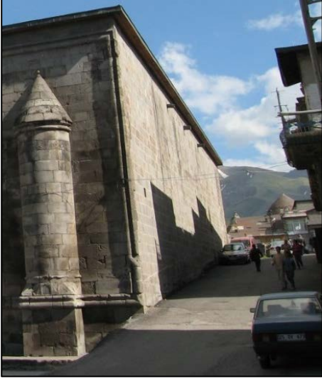
Foto. 36: Batı cephenin restorasyon öncesi sokak kotu
