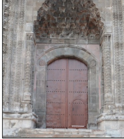
Foto. 34: Ahşap kapı kanatlarının onarımdan sonra temizlenmiş hali (büyük-küçük kapılar)
