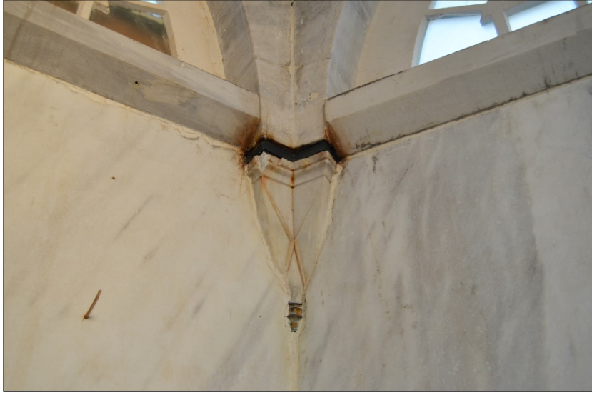
Foto. 15: İstanbul, Şehzade Mahmud Türbesi, Sonradan Kapatılan Açıklıkların İçten Görünüşü
