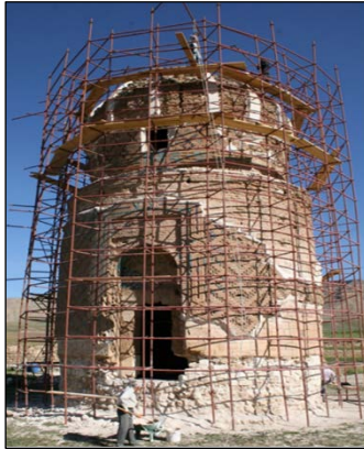
Foto. 5: Zeynel Bey T rbesi, tařmaya y nelik olarak yapılan m dahaleler (2016).
