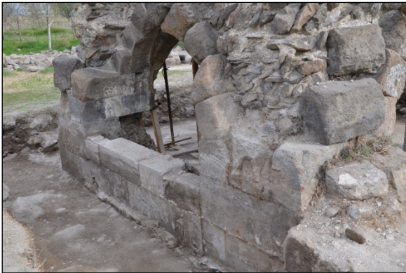
Foto. 15: Dört Kemerli Yapı, Güney Cephe
