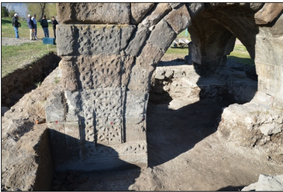
Foto. 9: Dört Kemerli Yapının Kuzeydoğu Ayağı
