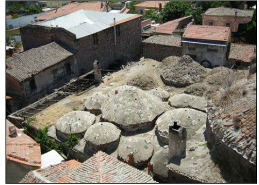
Foto. 2: Hamamın Çevresindeki Yapılaşma
