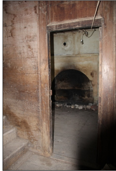
Foto. 8: Zemin Kattaki Ocak
