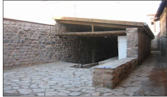
Foto. 26: Külhan Girişi ve Odunluk (Onarım Sonrası)
