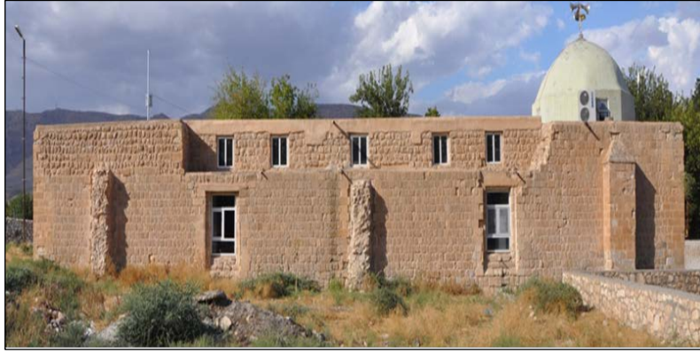
Foto. 6: Kızlar (Eyyubi) Camii, kuzey ve güney cepheleri.
