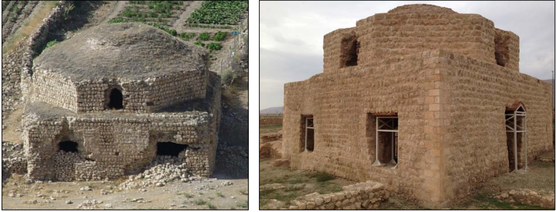
Foto. 20: Artuklu Hamamı, günümüze ulaşan soğukluk bölümü.
