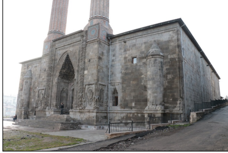
Foto. 2: Çifte Minareli Medrese'nin onarım sonrası ön görünümü
