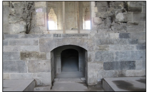
Foto. 18: Türbenin kriptada girişi (onarım sonrası)
