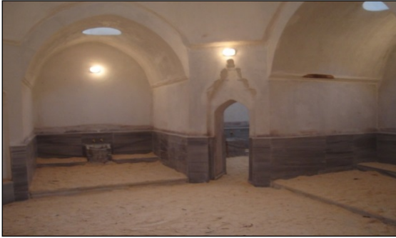
Foto. 25: Kadınlar Kısmı, Sıcaklık (Onarım Sonrası)
