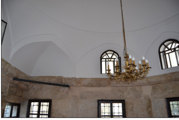
Foto. 3: İstanbul, Hatice Sultan Türbesi, Kubbeye Geçiş Bölgesi
