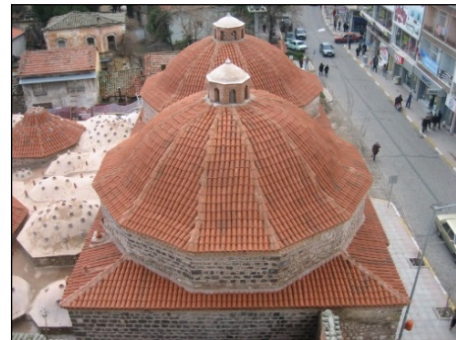
Foto. 22: Soyunmalık Kubbeleri (Onarım Sonrası)
