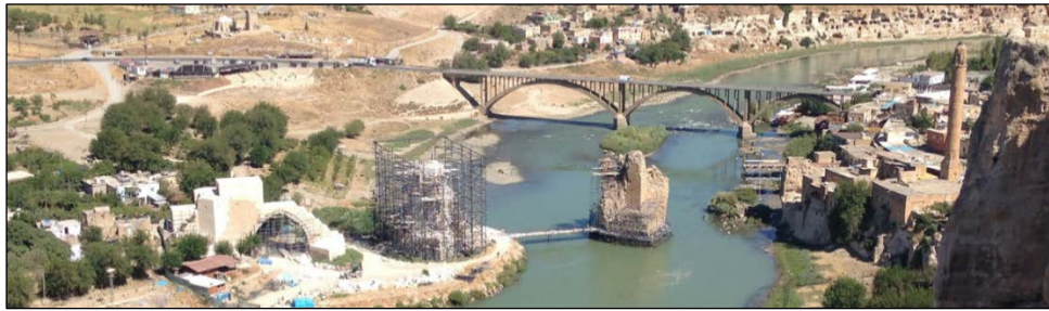
Foto. 23: Hasankeyf Köprüsü ve yapılan restorasyon çalışmaları
