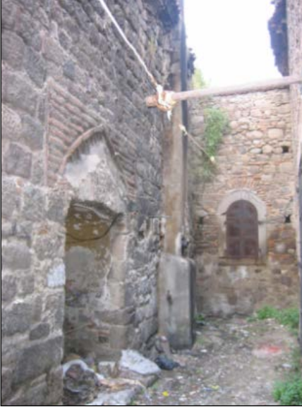
Foto. 17: Batı Cephe (Onarım Sonrası)
