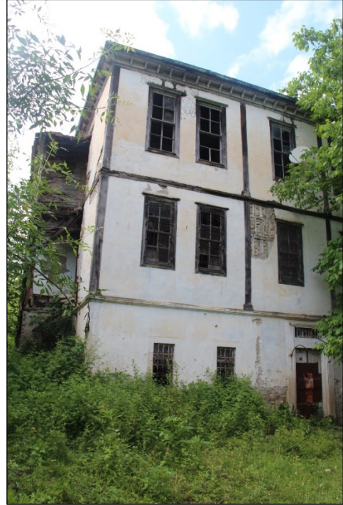
Foto. 5: Konağın Doğu Cephesi
