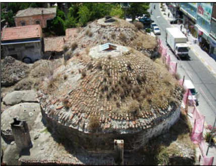
Foto. 21: Soyunmalık Kubbeleri (Onarım Öncesi)
