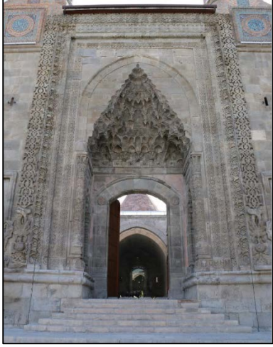
Foto. 33: Taçkapı önündeki değiştirilen basamaklar
