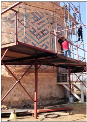
Foto. 5: Zeynel Bey T rbesi, tařmaya y nelik olarak yapılan m dahaleler (2016).
