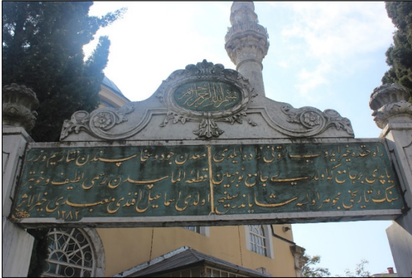
Foto. 2: Avlu Giriş Kapısı (Kuzey) Üzerindeki İnşa Kitâbesi
