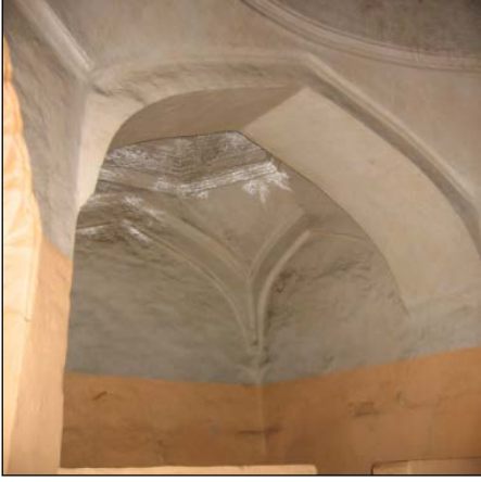
Foto. 11: Erkekler Kısmı Sıcaklığında Eyvan Örtü Sistemi
