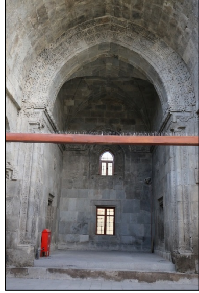
Foto. 61: Restorasyon sonrası batı eyvan
