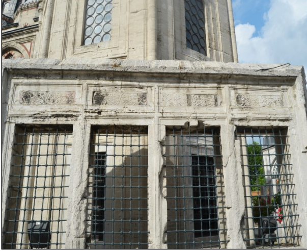
Foto. 11: İstanbul, İbrahim Paşa Türbesi ve İhata Duvarı
