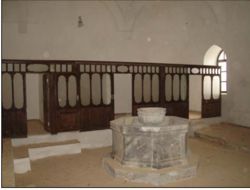
Foto. 23: Erkekler Kısmı (Onarım Sonrası)
