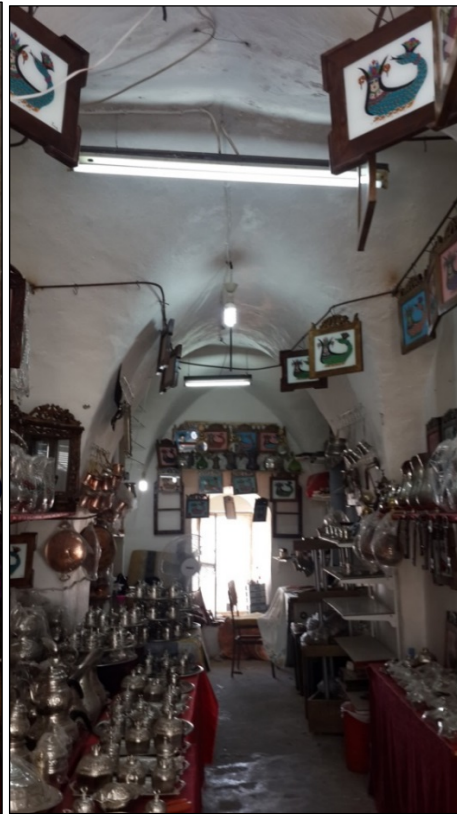
Foto. 5: Tellallar Çarşısı Dükkân Örtü Sistemlerinden Örnek
