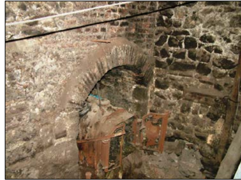
Foto. 8: Kemer Hamamı Külhan (Kaynak: Kütahya KVKBK Müdürlüğü arşivi119-2010 /Alıntı: Emine SARAÇ Kütahya Geleneksel Kent Yerleşimindeki Hamam Yapıları, Koruma Yaklaşımı ve Uygulamaların Analizi, Kültür ve Turizm Bakanlığı Uzmanlık Tezi)
