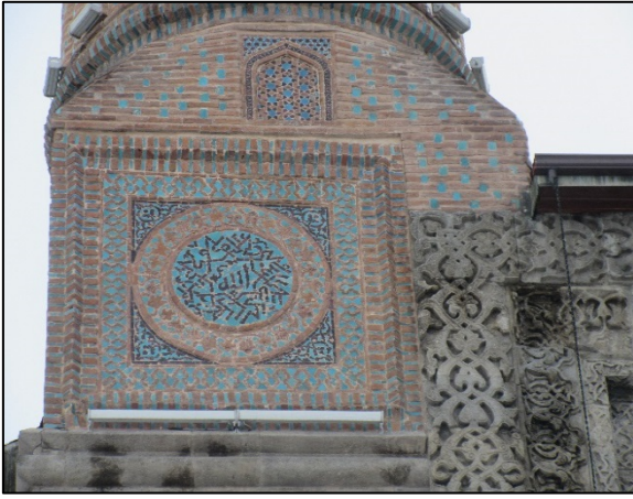
Foto. 9: Sol minare kaidesindeki çiniler
