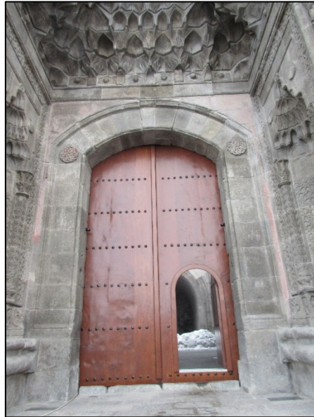
Foto. 35: Onarımdan sonra büyük-küçük kapıların açık durumu
