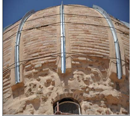
Foto. 5: Zeynel Bey T rbesi, tařmaya y nelik olarak yapılan m dahaleler (2016).
