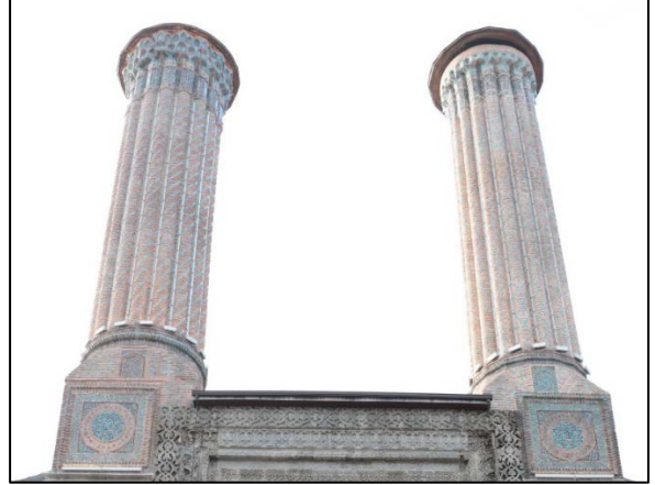
Foto. 8: Onarım sonrası çift minareler
