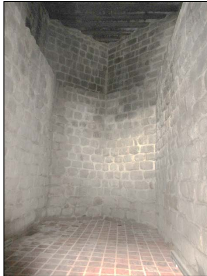
Foto. 47: Burcun içerisinin restorasyon sonrası durumu
