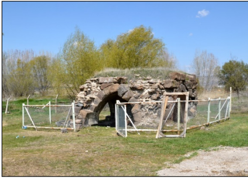
Foto. 2: Dört Kemerli Yapı Sondaj Öncesi
