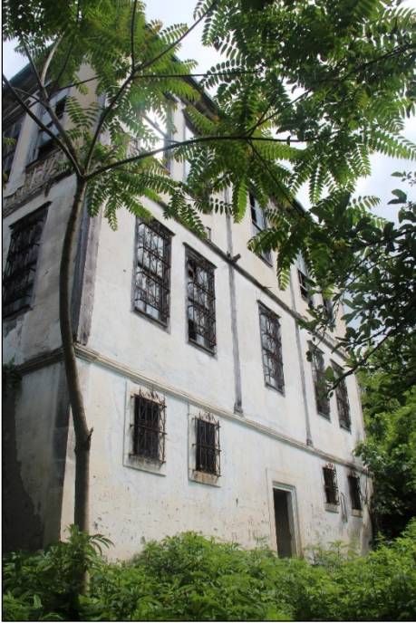
Foto. 4: Konağın Batı Cephesi
