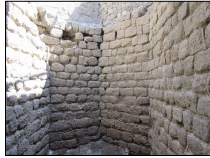
Foto.45: Burcun içerisi (temizlendikten sonra)
