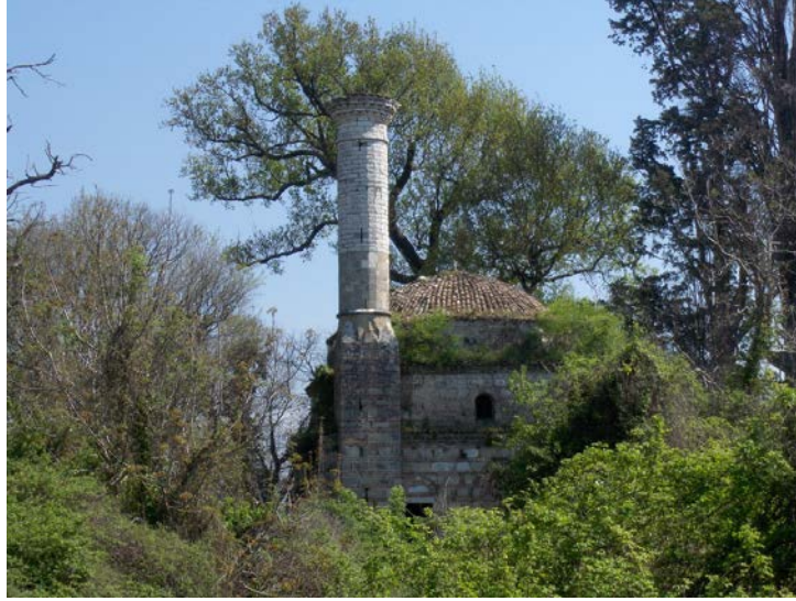
Foto. 12: FPC Minare ve batı cephesi (Kintis Christos GE).
