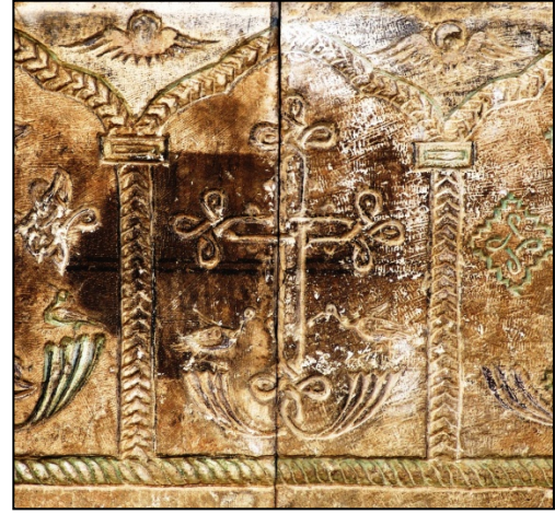
Foto. 15: Jamatun batı cephe taçkapı güneyi 10 Nolu Haçkar'daki akleylek.
