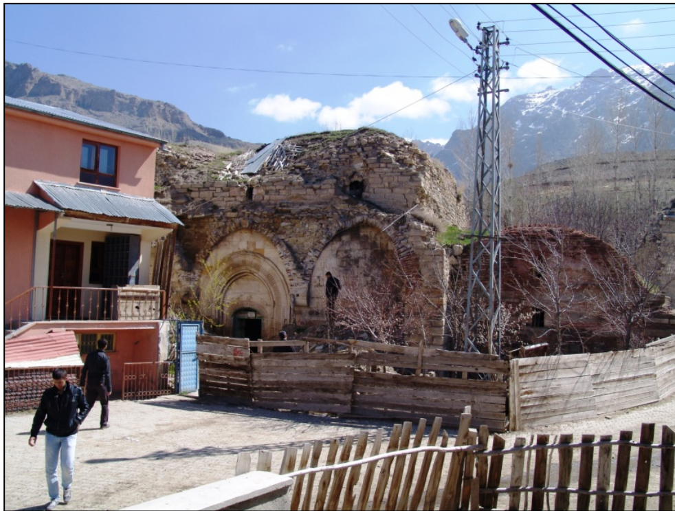
Foto. 5: Yedikilise Manastırı güneybatıdan görünüş (23.10.2011 Van Depremi Sonrası).
