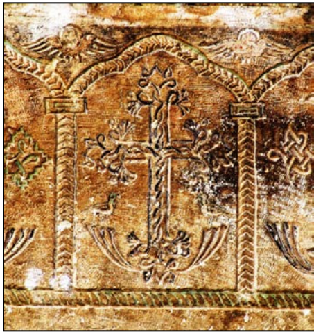
Foto. 16: Jamatun batı cephe taçkapı güneyi 12 Nolu Haçkar'daki akleylek.
