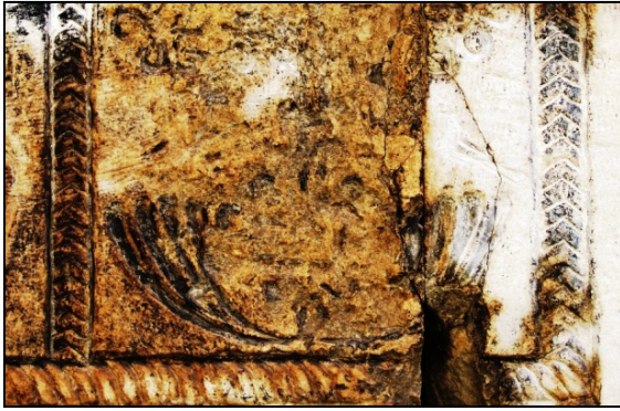
Foto. 20: Jamatun batı cephe taçkapı kuzeyi 3 Nolu Haçkar'daki saksığan.
