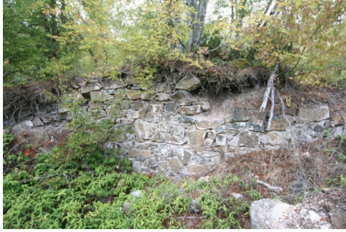
Foto. 4: Akbay Kalesi duvar dokusu.
