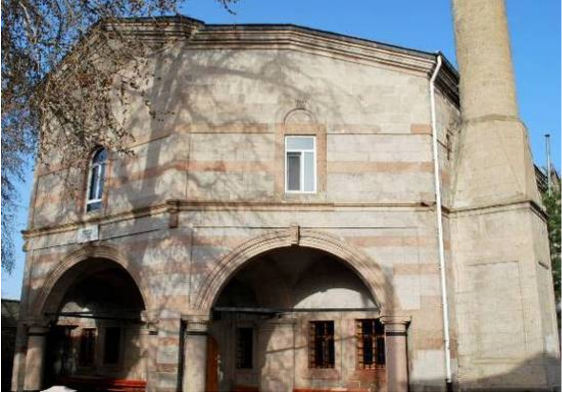
Foto. 8: Tamamen yenilenen batı cephenin genel görünüşü.
