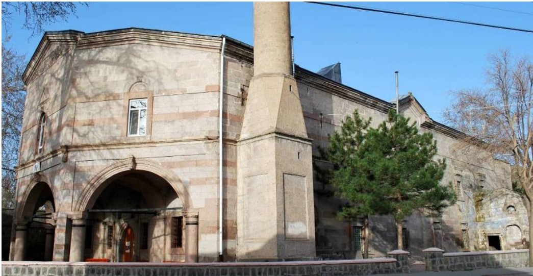
Foto. 1: Everek (Surb Toros) Ermeni Kilisesi genel görünüşü.
