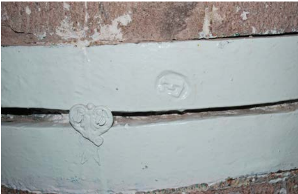
Foto. 11–12: Kaidelerdeki bilezikler üzerinde yer alan “F” damgası ve detayı.
