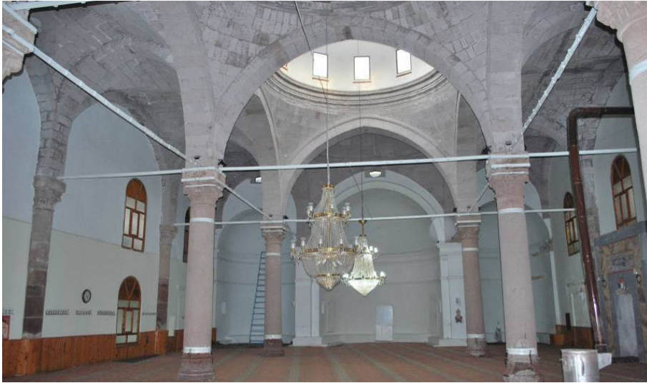
Foto. 10: Naosta kullanılan on iki adet tüm taş direk ve demir gergiler.
