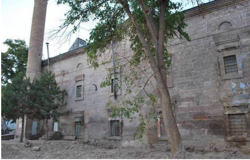
Foto. 2: Kilisenin güney cephe genel görünüşü.
