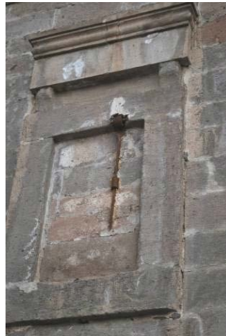
Foto. 4-5: Güney ve kuzey cephenin kapatılan pencereleri ile üzerindeki kılıçlar.
