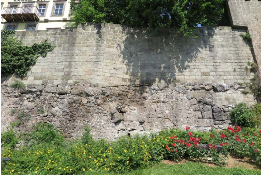
Foto. 9: Orta Kalenin batı cephesindeki kemerli kısımlar.
