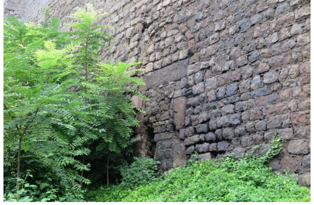
Foto. 8: Kuzeybatı köşede bulunan kapatılmış kapı.
