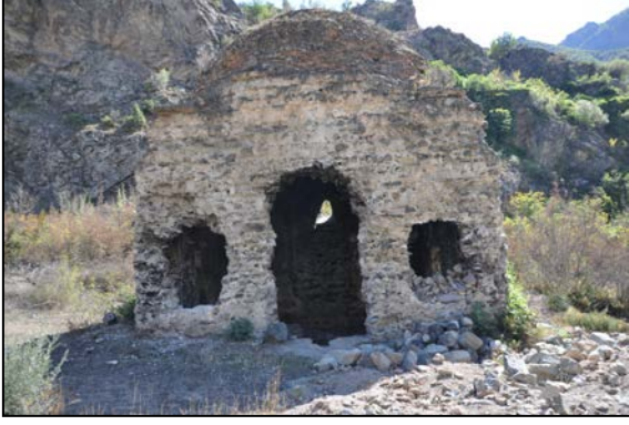
Foto. 6: Zeytinlik Köyü Aşağı Türbe, 2011.
