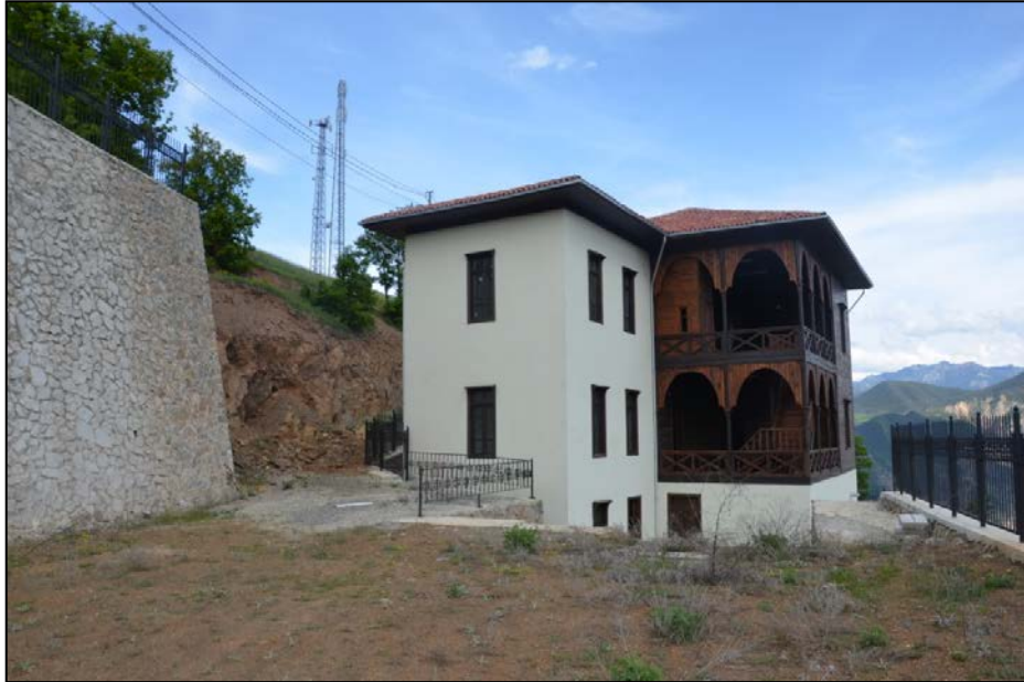
Foto. 20: Şükrü Ağa Konağı, 2016.
