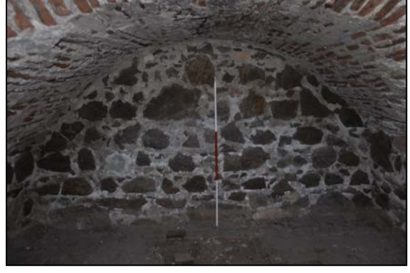
Foto. 7: Zeytinlik Köyü Aşağı Türbe, 2011.
