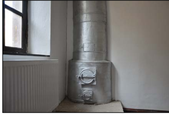
Foto. 19: Şükrü Ağa Konağı, 2016.
