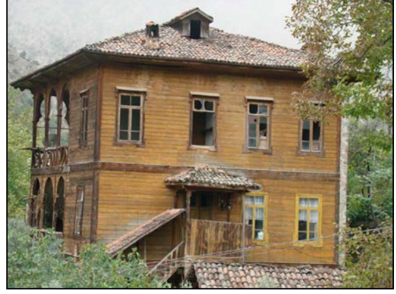
Foto. 18: Şükrü Ağa Konağı, 2010.
