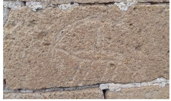
Foto. 5: Güneydoğu Cephesi. Süvari Tasviri.
