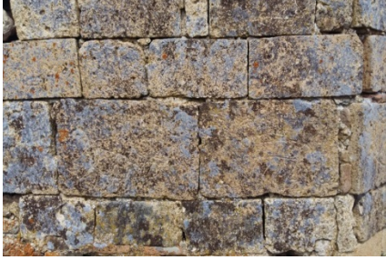
Foto. 15: Güneybatı Cephesi Figürler.
