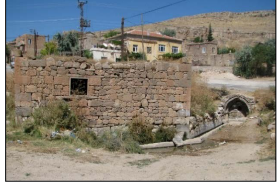
Foto.15: Bor-Havuzlu Köyü Çamaşırhanesi, güney cephe
