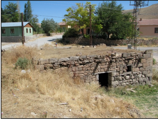
Foto. 16: Bor-Havuzlu Köyü Çamaşırhanesi, batı cephe
