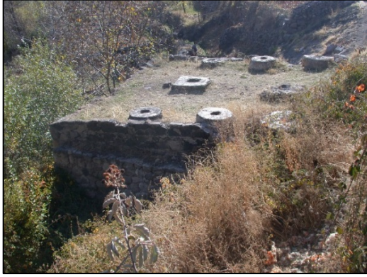
Foto. 10: Altunhisar/ Yeşilyurt Kasabası - Dabahne Çamaşırhanesi, genel görünüş
