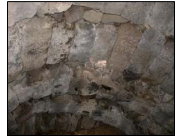
Foto. 14: Altunhisar/ Yeşilyurt Kasabası-Dabahne Çamaşırhanesi, örtü sistemi
