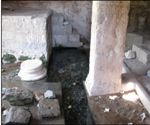
Foto. 18: Bor-Havuzlu Köyü Çamaşırhanesi, iç mekân
