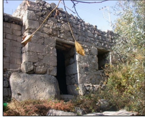
Foto. 11: Altunhisar/ Yeşilyurt Kasabası - Dabahne Çamaşırhanesi, güney cephe
