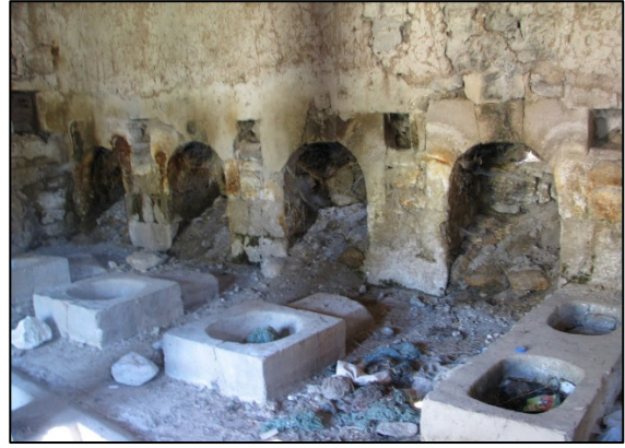
Foto. 17: Bor-Havuzlu Köyü Çamaşırhanesi, iç mekân
