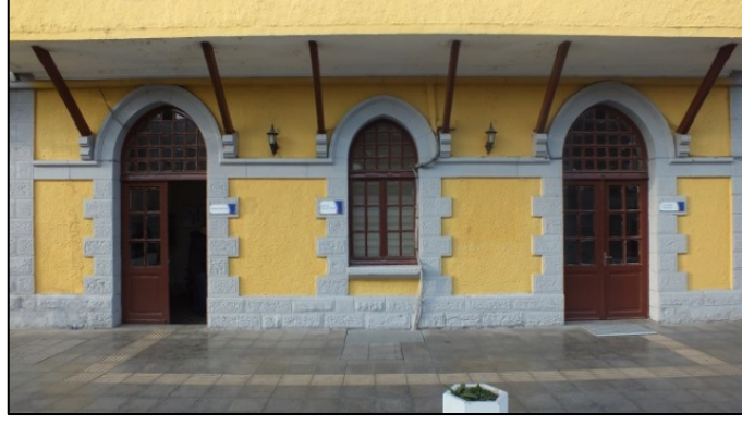
Foto. 14: Kapı ve pencere söveleri. Taş kaplamalar
