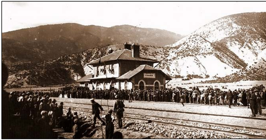
Foto. 13: 1930'lu yıllarda Karabük İstasyonu
