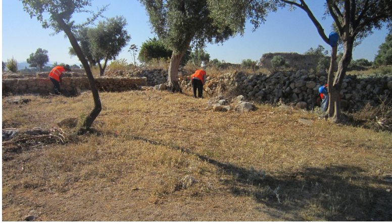
Foto. 2: Temizlik Çalışmaları (Sur İçinde)
