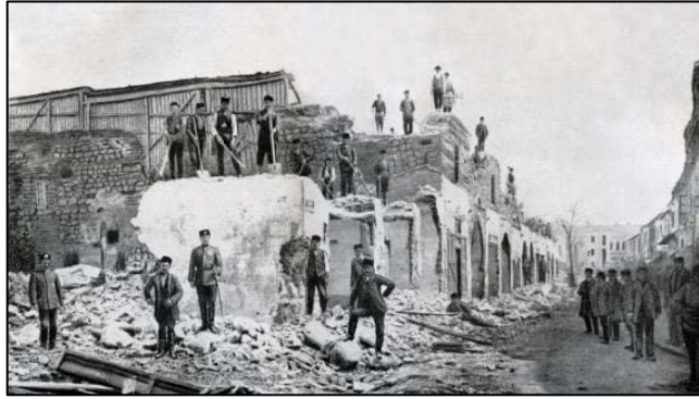
Foto. 39: Yıkım çalışmalarını gösteren eski bir resim
