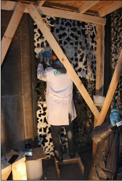
Foto. 10 – 11: Şebeke Yüzeyinde BTA Uygulaması (Uğur Genç arşivinden)
