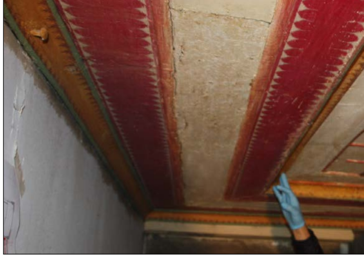
Foto. 1: Okuma Tavanı restorasyon çalışmaları
