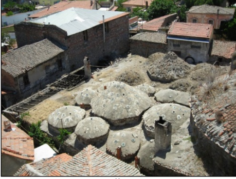
Foto. 19: Örtü sistemi (onarım öncesi)
