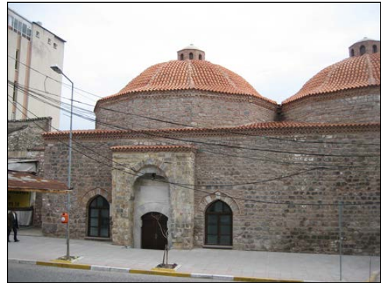
Foto. 16: Batı Cephe (Onarım Sonrası)
