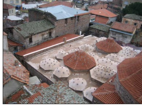
Foto. 20: Örtü sistemi (onarım sonrası)
