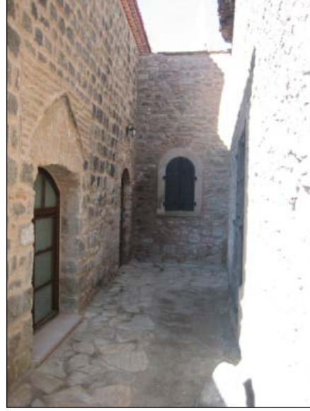
Foto. 18: Kuzey Cephe (Onarım Sonrası)
