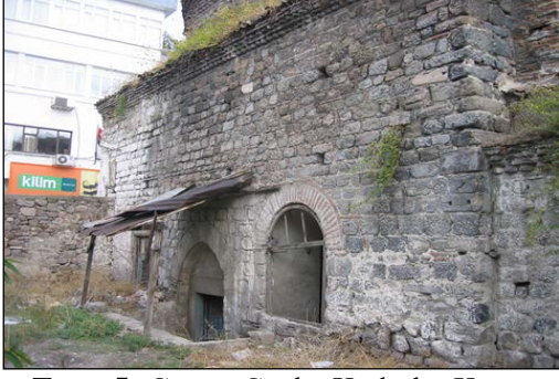
Foto. 5: Güney Cephe Kadınlar Kısmı
