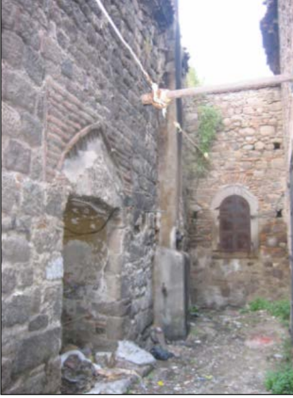
Foto. 17: Batı Cephe (Onarım Sonrası)
