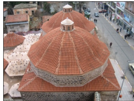
Foto. 22: Soyunmalık Kubbeleri (Onarım Sonrası)
