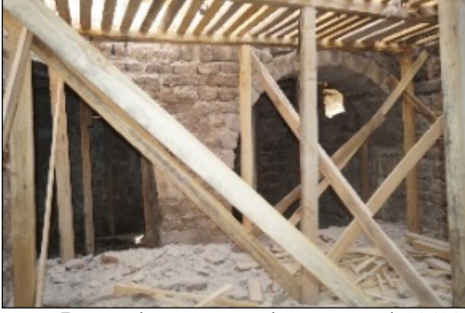
Foto. 5: Darphane, güney batı yönündeki ikiz kemerli odanın görünüşü (B. Deniz, 2016)
