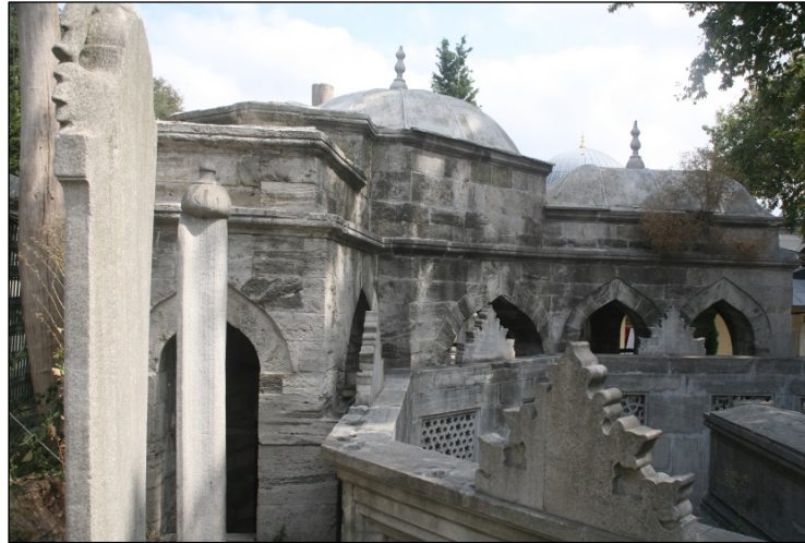
Foto. 3: Haydar Mirza Türbesi batı cephesi.
