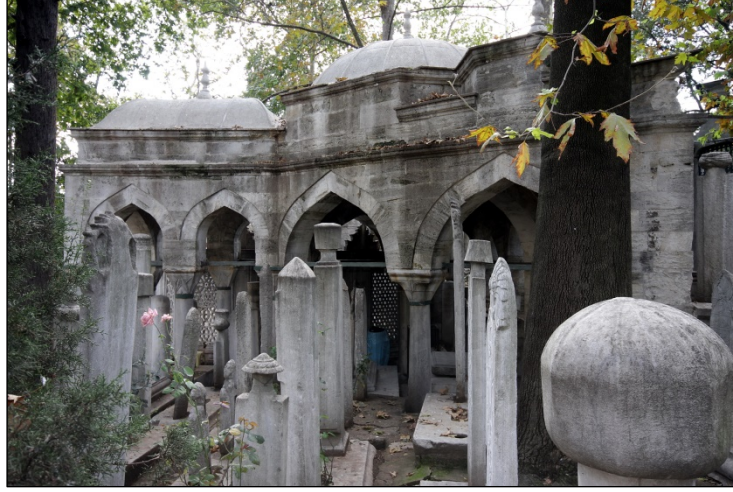
Foto. 2: Haydar Mirza Türbesi doğu cephesi.
