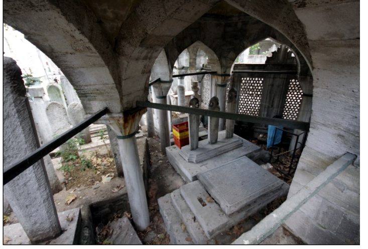
Foto. 10: Haydar Mirza Türbesi köşe bağlantısı.
