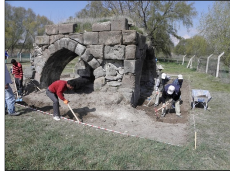
Foto. 3: Dört Kemerli Yapı Çevresindeki Çalışmalar
