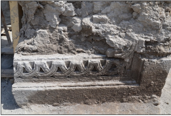
Foto. 13: Dört Kemerli Yapı, Güneybatı Ayak
