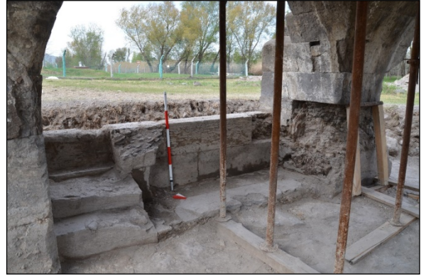
Foto. 16: Dört Kemerli Yapı, İç Kısımdaki Merdiven
