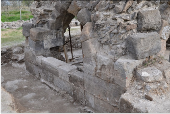
Foto. 15: Dört Kemerli Yapı, Güney Cephe
