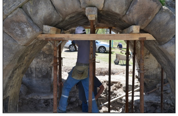
Foto. 12: Dört Kemerli Yapıda Askıya Alma İşlemi
