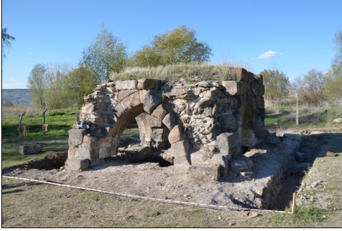
Foto. 5: Dört Kemerli Yapı Kuzey ve Doğu Cepheler
