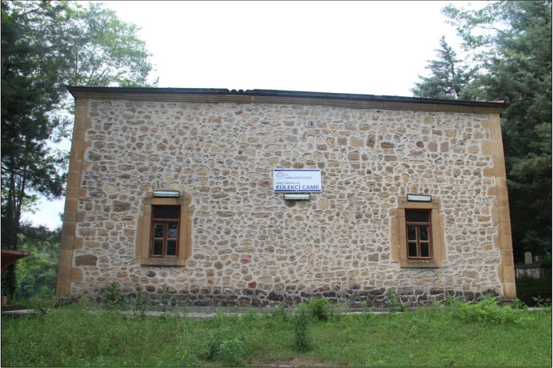
Foto. 18: Caminin Güney Cephesi
