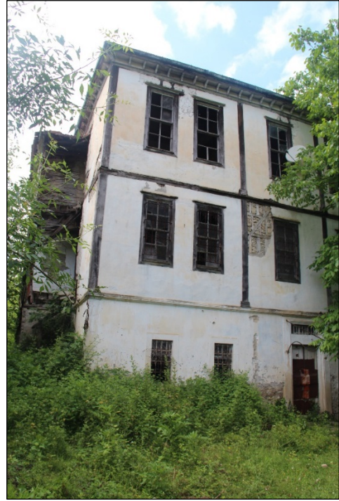
Foto. 5: Konağın Doğu Cephesi
