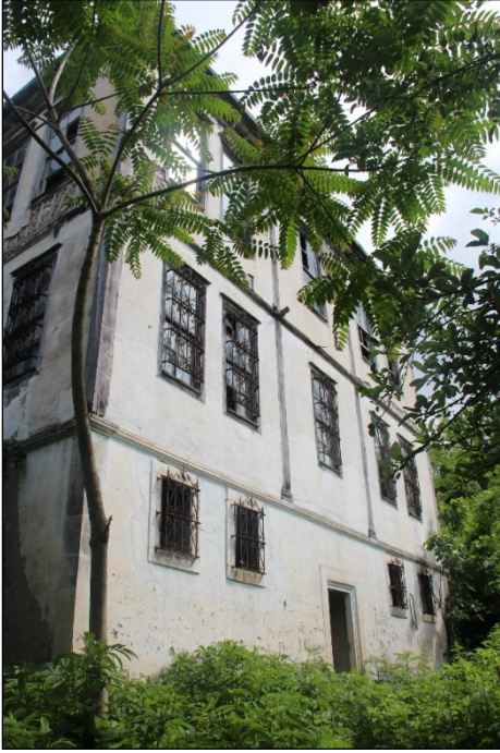
Foto. 4: Konağın Batı Cephesi
