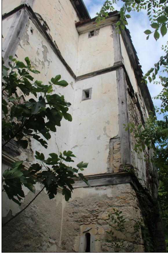
Foto. 6: Konağın Güney Cephesi
