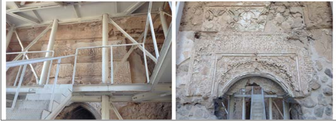
Foto. 19: Koç Camii iç aksamında koruma amaçlı destekleme sistemi.
