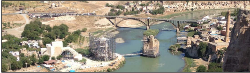
Foto. 23: Hasankeyf Köprüsü ve yapılan restorasyon çalışmaları
