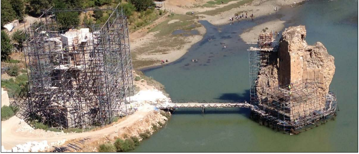
Foto. 24: Hasankeyf Köprüsü'nde yapılan restorasyon çalışmaları.
