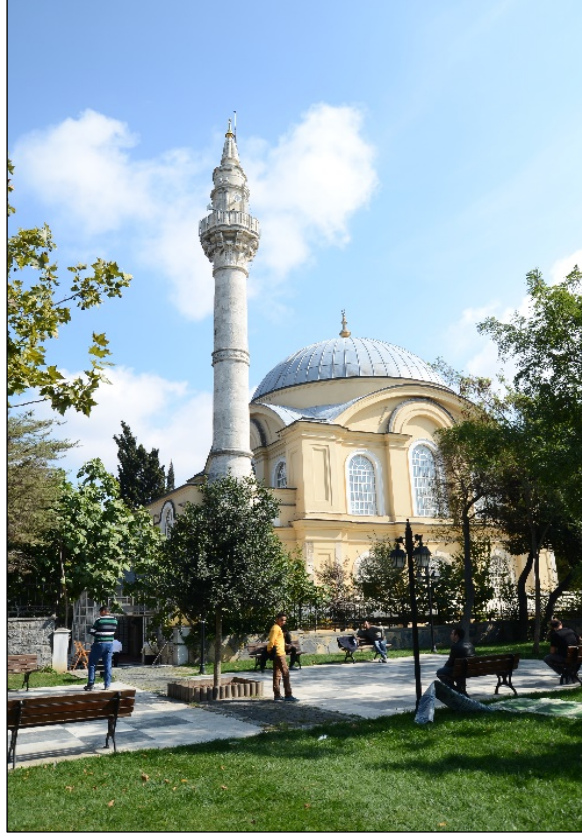
Foto. 1: Altunizâde Camii Doğu Cephesinden Genel Görünüm
